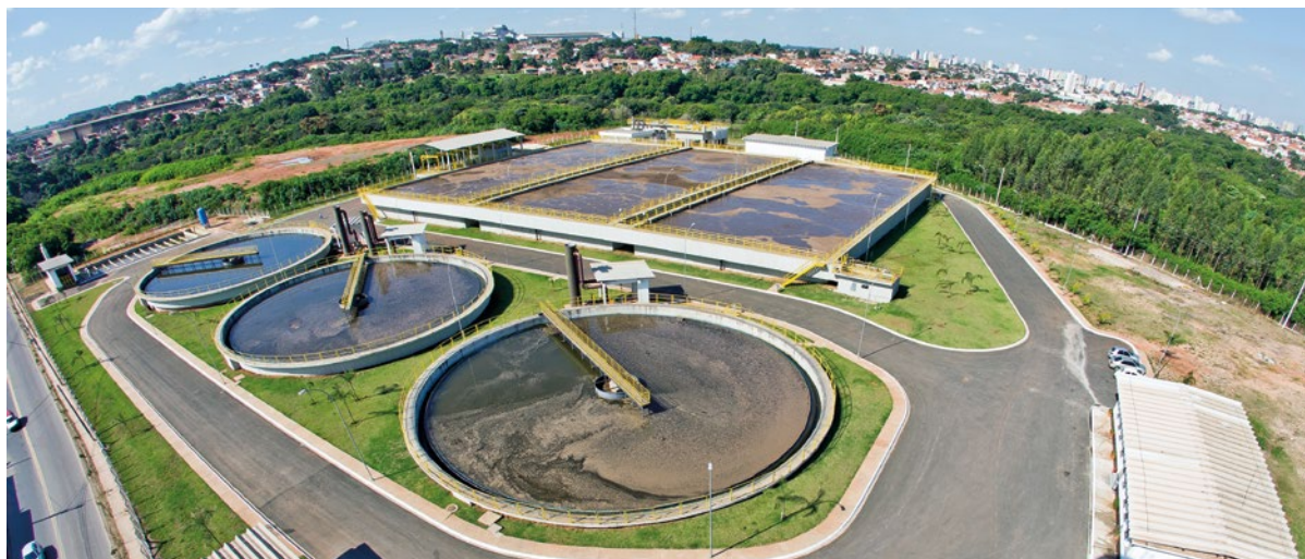
Estação de Tratamento de Esgoto Ponte do Caixão, em Piracicaba, um dos investimentos feitos pela Mirante que fazem com que a PPP tenha destaque em rankings de saneamento.
