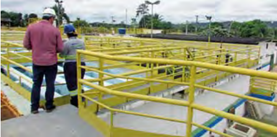
Colaboradores em visita técnica à ETA Rio Jamari, responsável pelo abastecimento de água tratada da cidade de Ariquemes.
